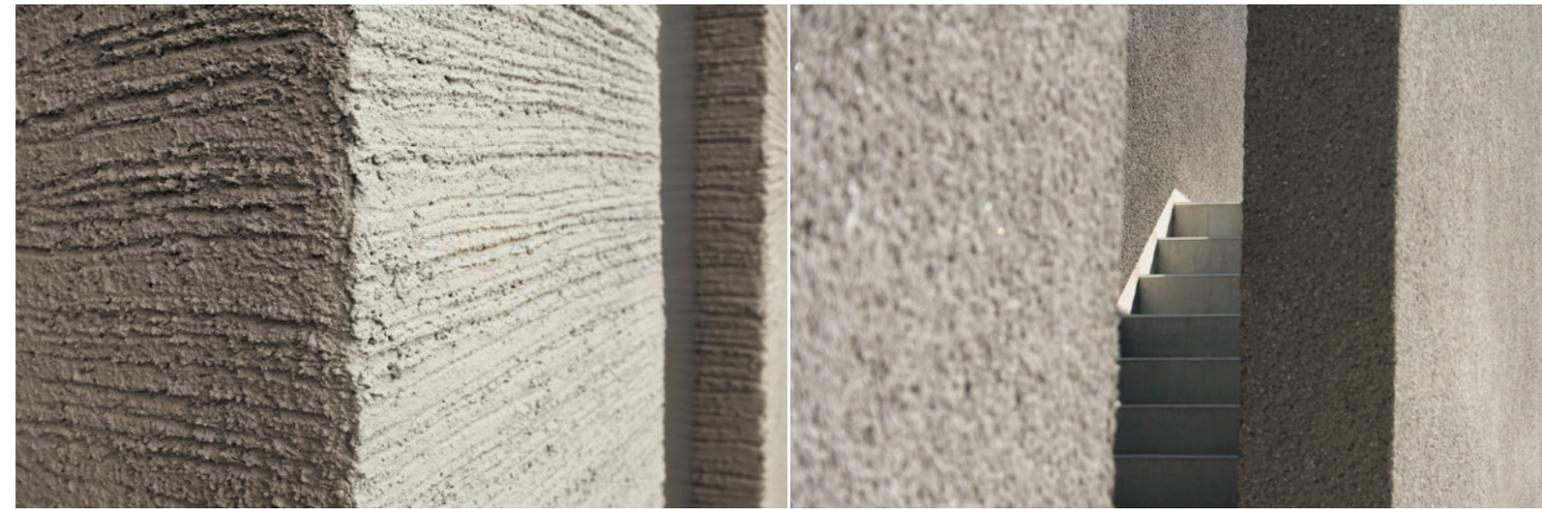
**RICHTIG KÖRNIG:** Besenstrich mit grobem Korn und Eibenbesen, freihändig gezogen (Bild links) und 7-mm-Edelkratzputz im Kontrast zu Sichtbeton (Bild rechts).
