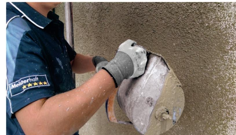
KURBELN UND LOS! Spritzputz wird mit dem „Wormser“ in mehreren Lagen aufgespritzt.
