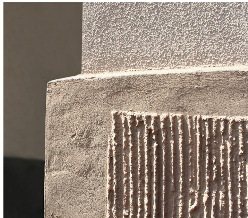
SPRITZPUTZ AN DER FASSADE: Sockelputz mit Kammzug und freihändigem Glattputz.
