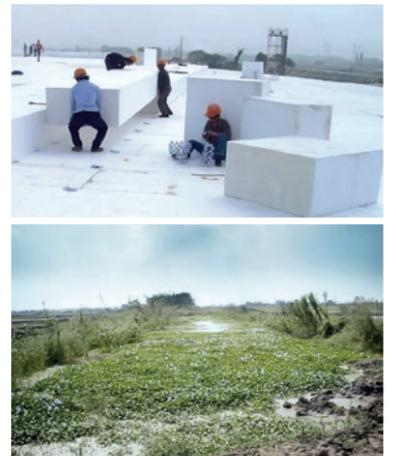
IN SHANGHAI musste die gesamte Rennstrecke mit Spezial-Styropor unterlegt werden, da das Bauland einem Sumpf glich.
