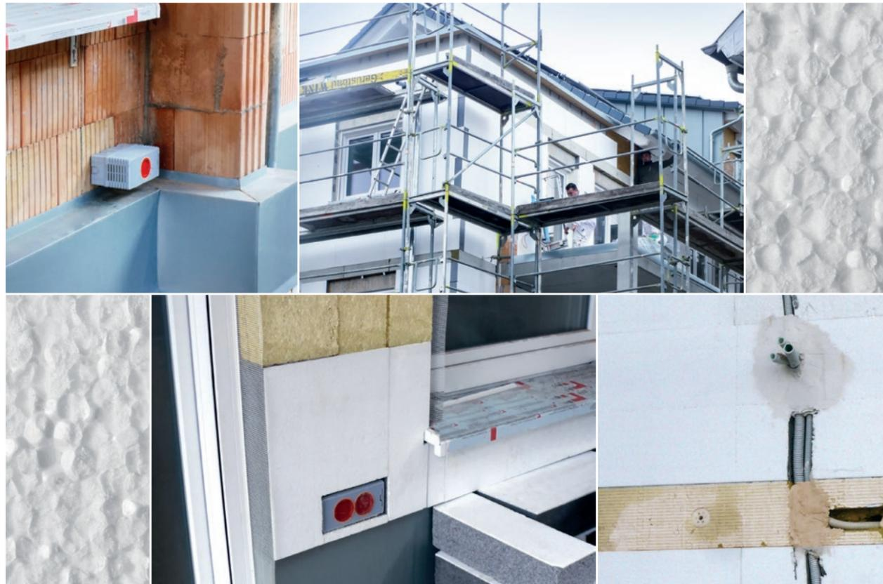
SEITLICHER ANSCHLUSS des Brandriegels an thermisch getrennter Kragplatte mit nachgewiesenem Feuerwiderstand (Bild oben rechts). Im Vorfeld geplante Elektroinstallation (Bild oben links). In das WDVS integrierte Elektroinstallation mit darüber liegendem Brandriegel (Bild unten links). Unzulässige Durchdringungen des Brandriegels/WDVS (Bild unten rechts).
