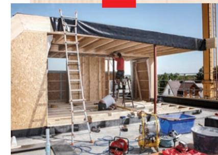
Q4: Im Fall eines Flachdaches haben Sie als Zimmerer ja auch das Problem, dass die Konstruktion nach außen dicht ist.
